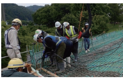
現場打ちコンクリート床版の施工
