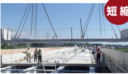
プレキャストコンクリート床版の施工
